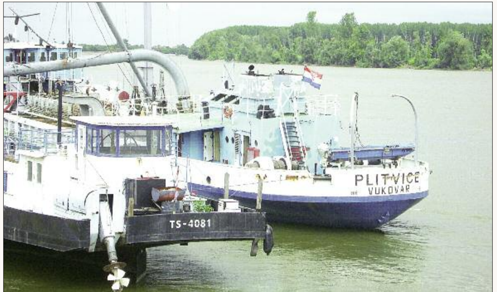
Svakoga dana kroz brodski cjevovod prođe 1.320 prostorna metra pijeska i vode
