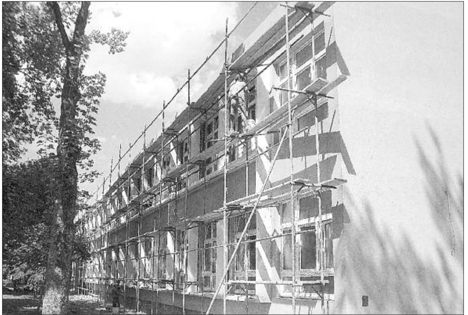
Obnova traje devet mjeseci, izvođač radova obećava da će škola biti obnovljena do jeseni
