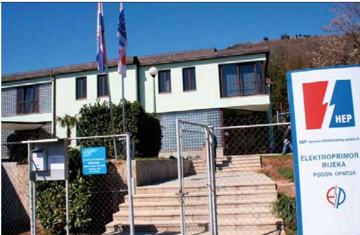
Nova poslovno-pogonska zgrada Pogona Opatija (s bočne i prednje strane)
